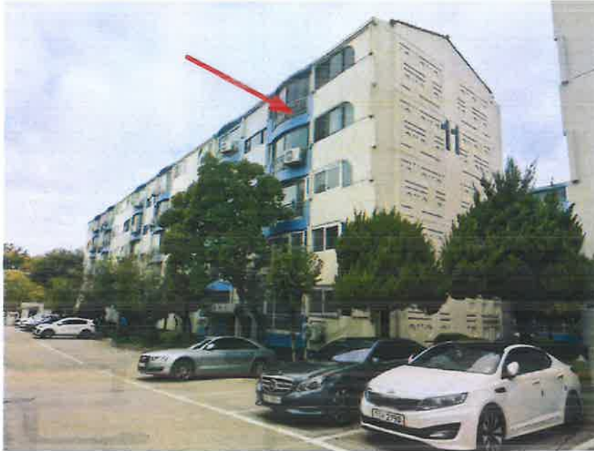
한양아파트 11동 전경 - 남동측에서 촬영
